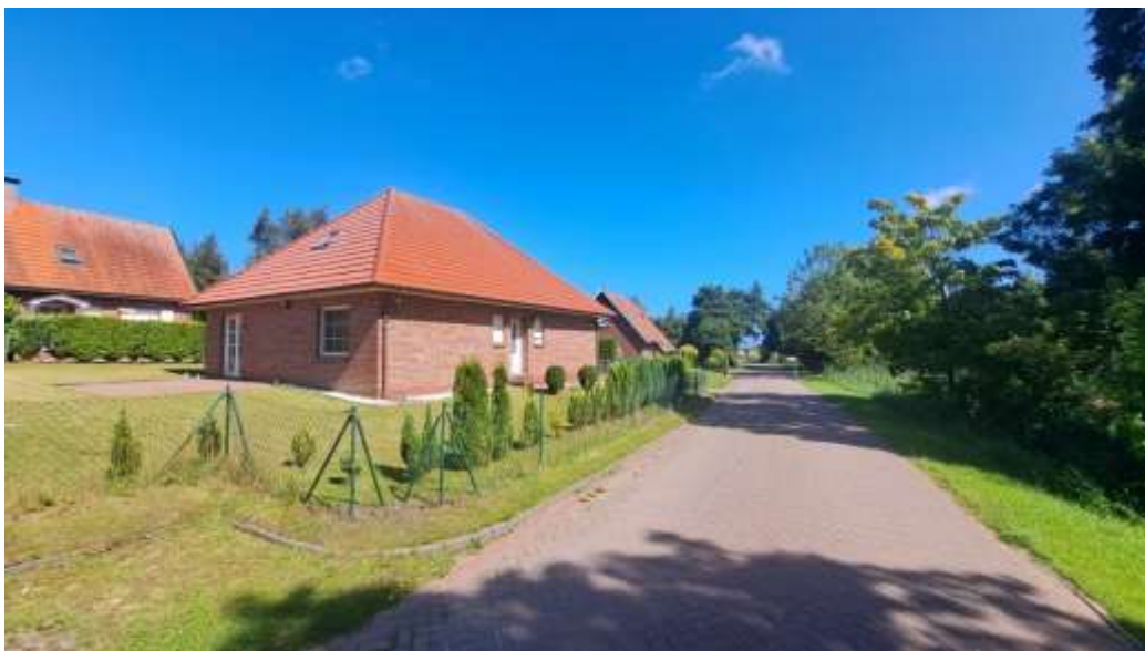
Anliegerstraße – Blickrichtung zum Deich
